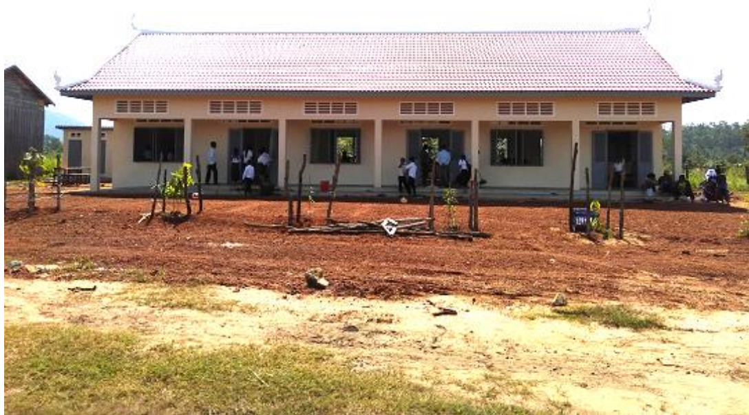
2022年10月21日に完成した新校舎（正面）
